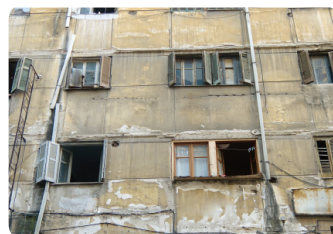
老朽化した住宅街の改修
