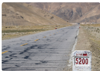
道路・交通インフラの調査
